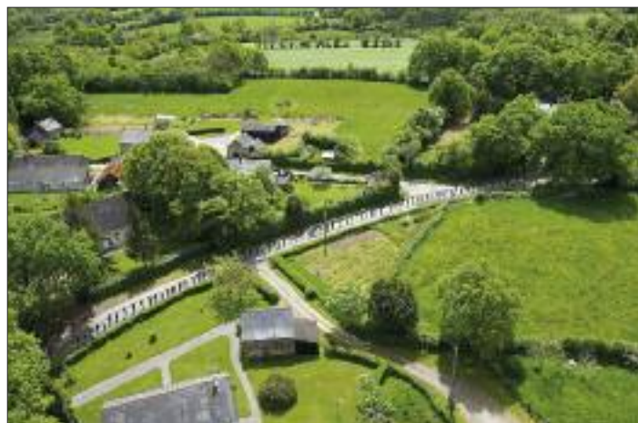
Photo A. Boqueuf - ACIPRA 2013.
